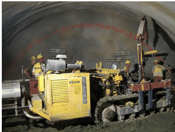
Aktuelle Vortriebsposition: Unter der Gleinzerstraße
