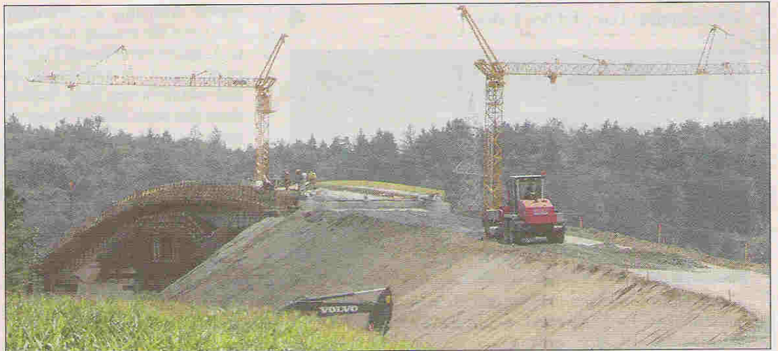
Milliardenprojekt Koralmbahn: Zwischen Hengsberg und Wettmannstätten wird eifrig gebaut.
