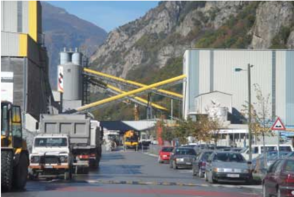
Bild 1. Aufbereitungsanlage und eingehauste Förderbänder, Baustelle St. Gotthart
